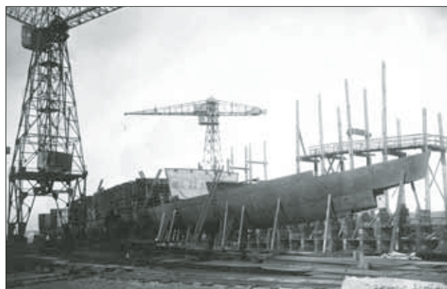
Le début de la construction de la coque de l'Aigle à Dunkerque. (SHD, CAAP Châtelleraut)
