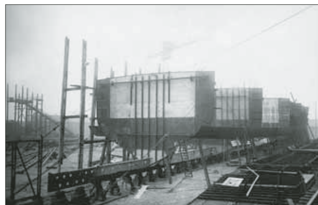
Mise en place des cloisons transversales de l'Aigle, sur cale à Dunkerque ; (SHD, CAAP Châtelleraut)
