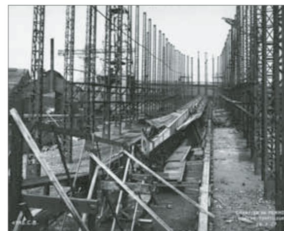
La quille du Da 2, futur Valmy, sur cale à Penhoët le 28 juillet 1927.
